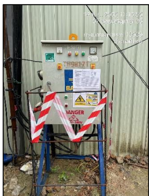
ภาพที่ 54 ติดตั้งแผงควบคุมไฟฟ้าและเครื่องตัดกระแสไฟฟ้าพร้อมวิธีตรวจสอบดูแผงไฟฟ้า
