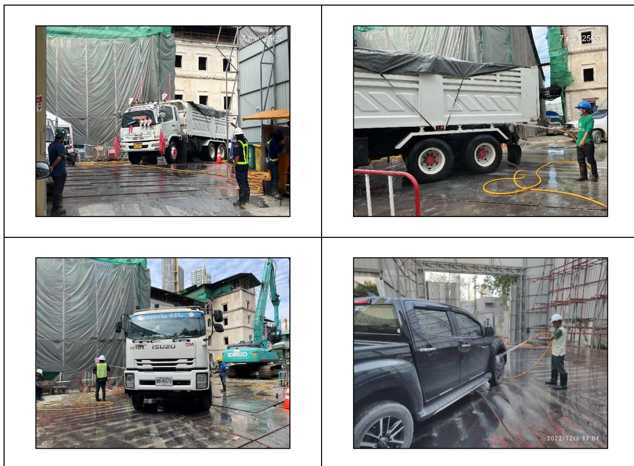
ภาพที่ 18 ฉีดล้างด้วยน้ำแรงดันสูง
