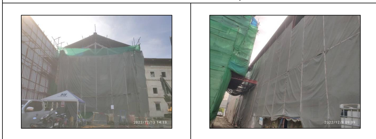
ภาพที่ 19 ติดตั้ง Mesh Sheet (แบบกันไฟลาม)
