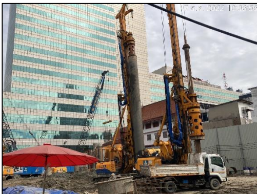
ภาพที่ 26 เสาค้ำแบบเจาะ
